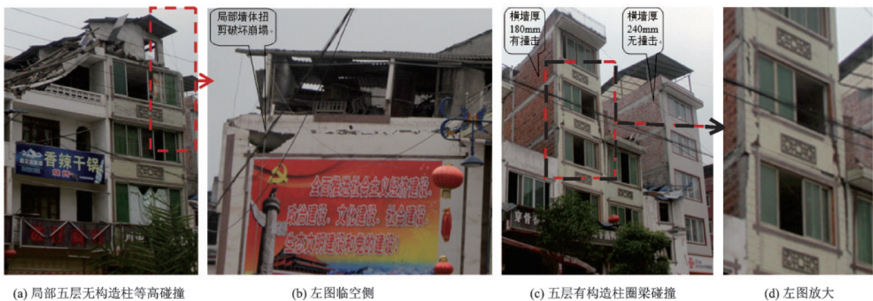
图8 宝兴县灵关镇8度区单开间砌体房屋碰撞震害照片
