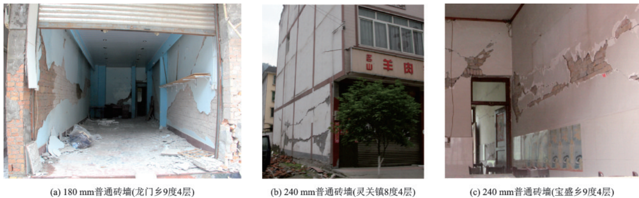
图5 底层横墙震害现场照片
